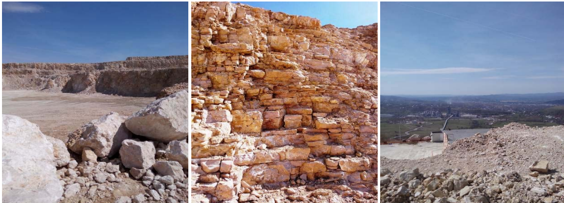
Fig. 2 Mateiaș-Dealul Hulei limestone quarry
